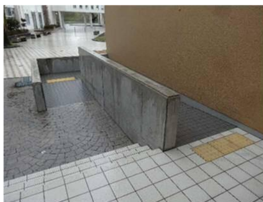
図Ⅱ-B-3-5 校舎出入口スロープ
