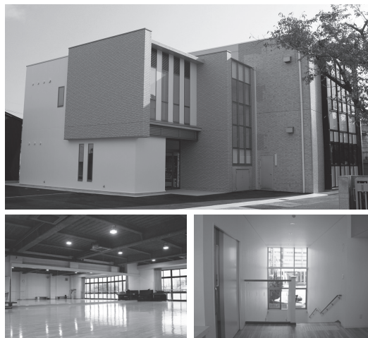
F館改築工事了
